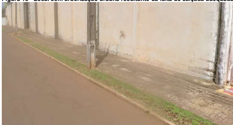
Figura 18 - Local sem arborização urbana resultante da falta de calçada adequada.
