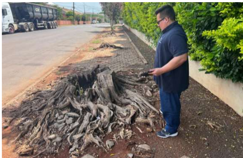
Figura 19 – Remoção de árvores sem a remoção dos tocos.
